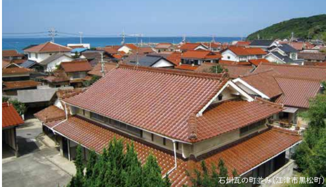
石州瓦の町並み(江津市黒松町)
